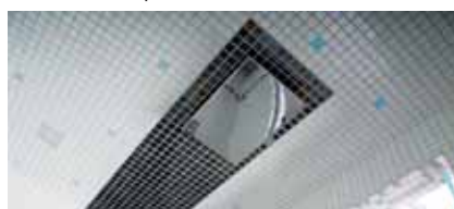
Celkový pohled na strop s hlavovou sprchou.
